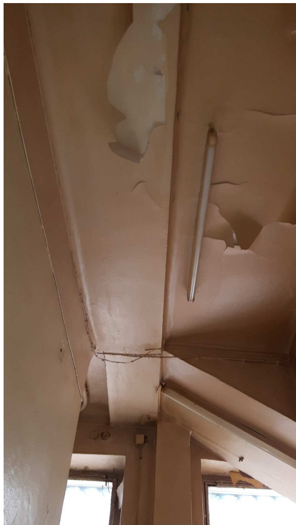
Fot. 5. Podciąg pod schody, złuszczenie farby
