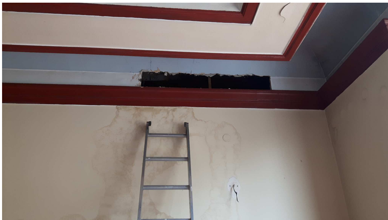
fot.3 Wnęka pod stropem parteru, widoczne zawilgocenia
