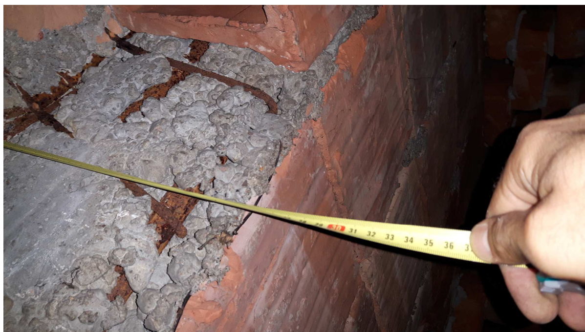
Fot. 2. Uszkodzenie stropu nad piwnicą – widoczne odkryte zbrojenie
