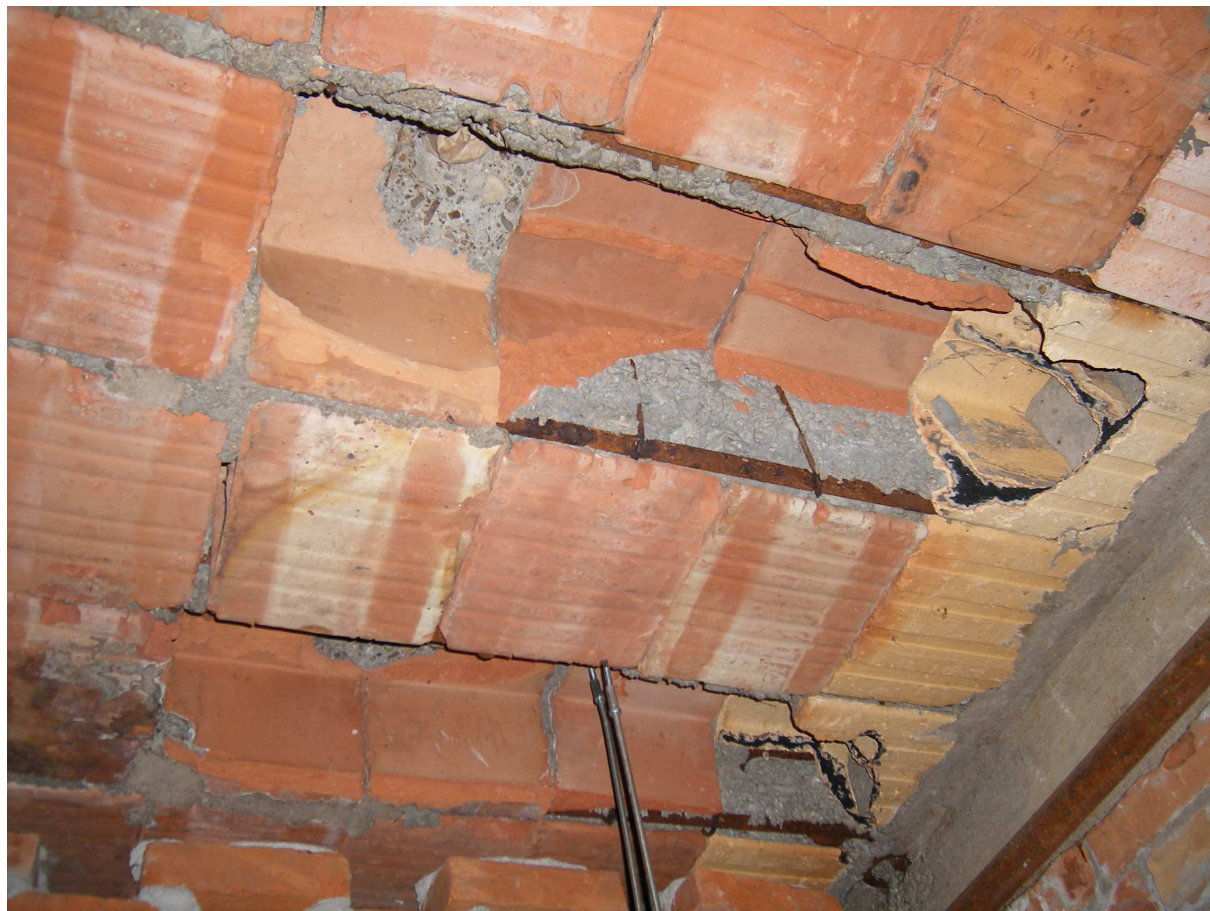
Fot. 1. Uszkodzenie stropu nad piwnicą – widoczne odkryte zbrojenie
